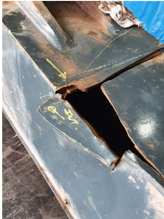
Figura 30 - Rompimento total da estrutura soldada
