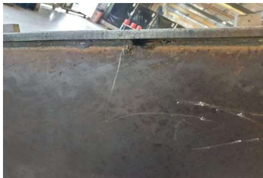
Figura 25 - Porosidade e cordão descontinuo
