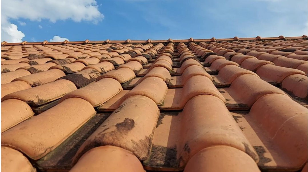
Figura 27 – Telhado da cobertura
