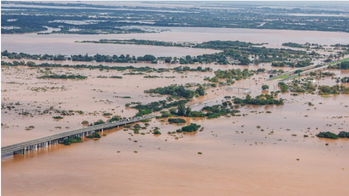
Figura 3: Estradas e pontes bloqueadas pela maior enchente do Rio Grande do Sul
