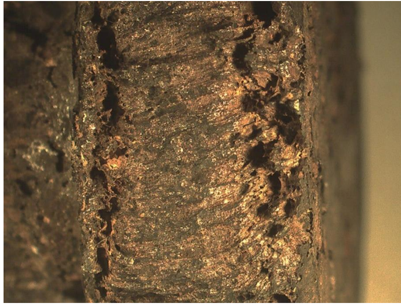
Figura 28 Cabeça do parafuso 2 após a corrosão
